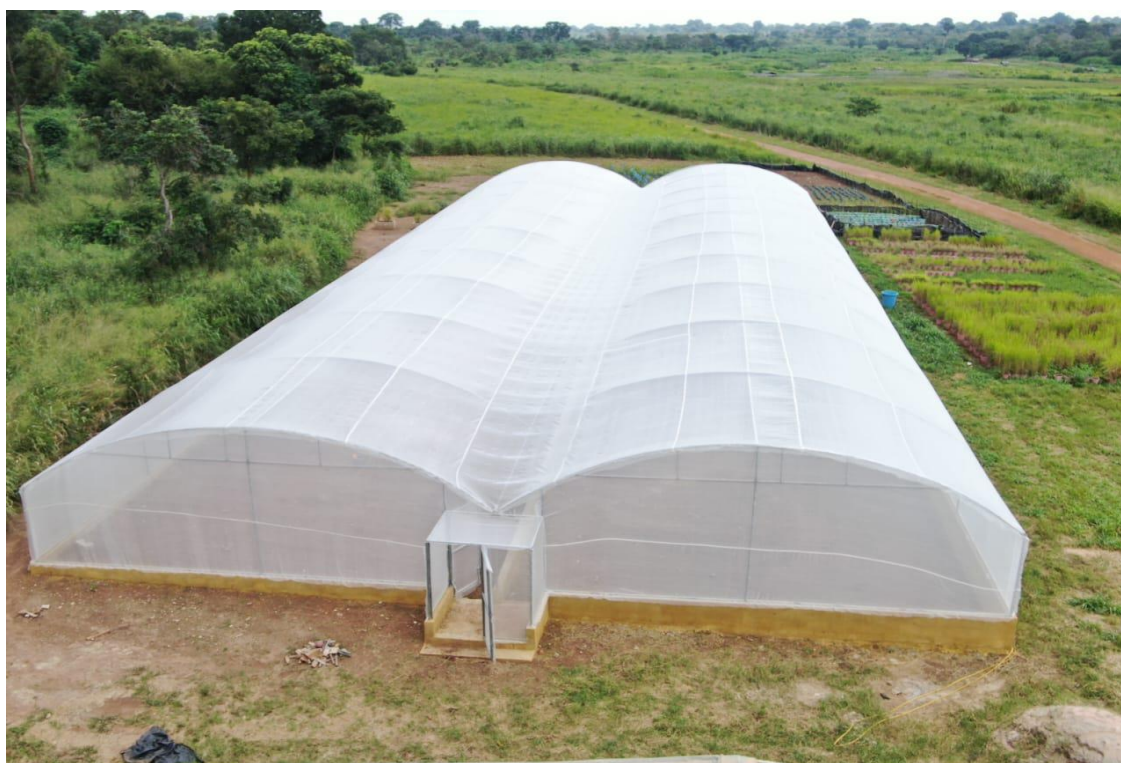
Figure 2: Réalisation du prototype sur le site d'Africa Rice à Bouaké
